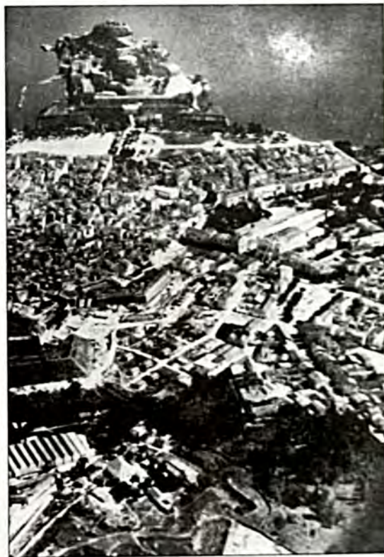
Τμήμα αεροφωτογραφίας της πόλης λίγα χρόνια πριν ξησπάσει ο Β' Παγκόσμιος Πόλεμος. Σε πρώτο πλάνο διακρίνονται από αριστερά προς τα δεξιά: Το εργοστάσιο Λασιότη (δεν υπάρχει πια), το κτίριο του Γηροκομίου με προσφυγικές κατοικίες δεξιά του, το Κοιμητήριο των Γραικών και το Κοιμητήριο των Ποινικών.
